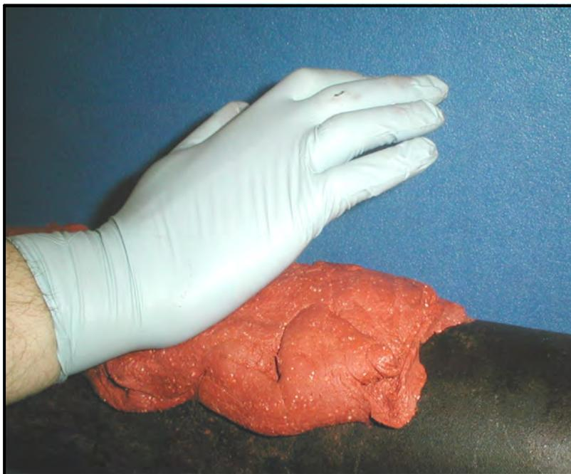
**Рис. 2-7. Нанесение демпфирующего материала DMP-3**
